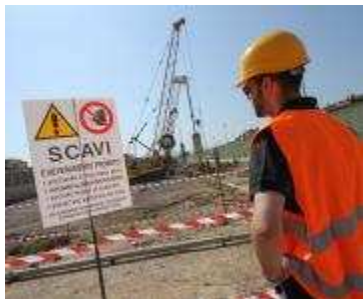
Sopralluogo al cantiere Tav di Firenze (Pressphoto)
