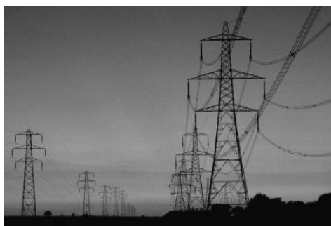
Tralicci dell'energia elettrica.
